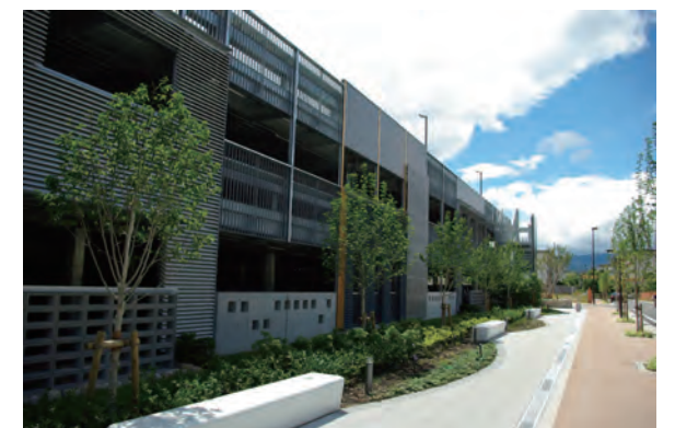
沿道景観要素としてデザインした立体駐車場
